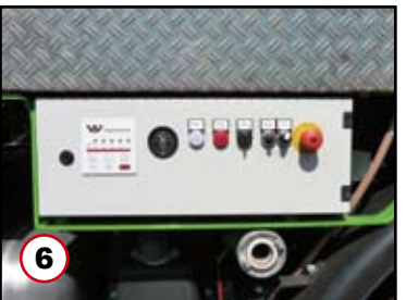
6 Vezérlőszekrény diagnosíz modulal és vészvezérléssel Schaltschrank mit Diagnosemodul und Notsteuerung
