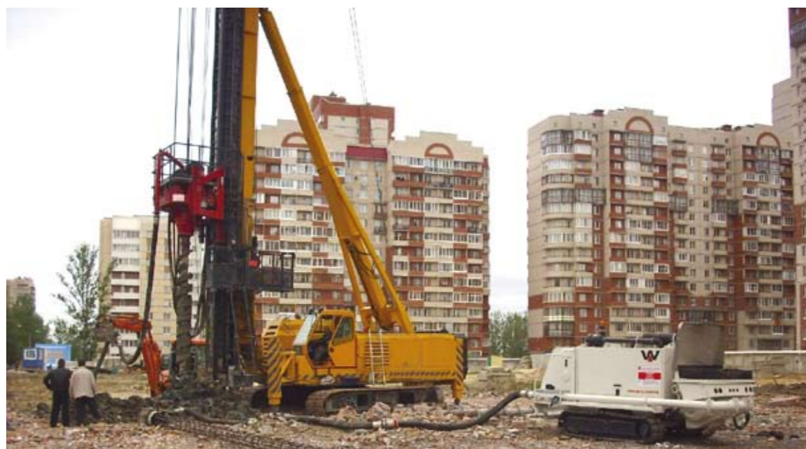
Fúrógép önjáró betonszivattyúval építési területen Baustelle mit Bohrergerät in Kombination mit Kettenbetonpumpe
