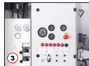
3. Kapcsolószekrény Schaltschrank mit Notsteuerung
